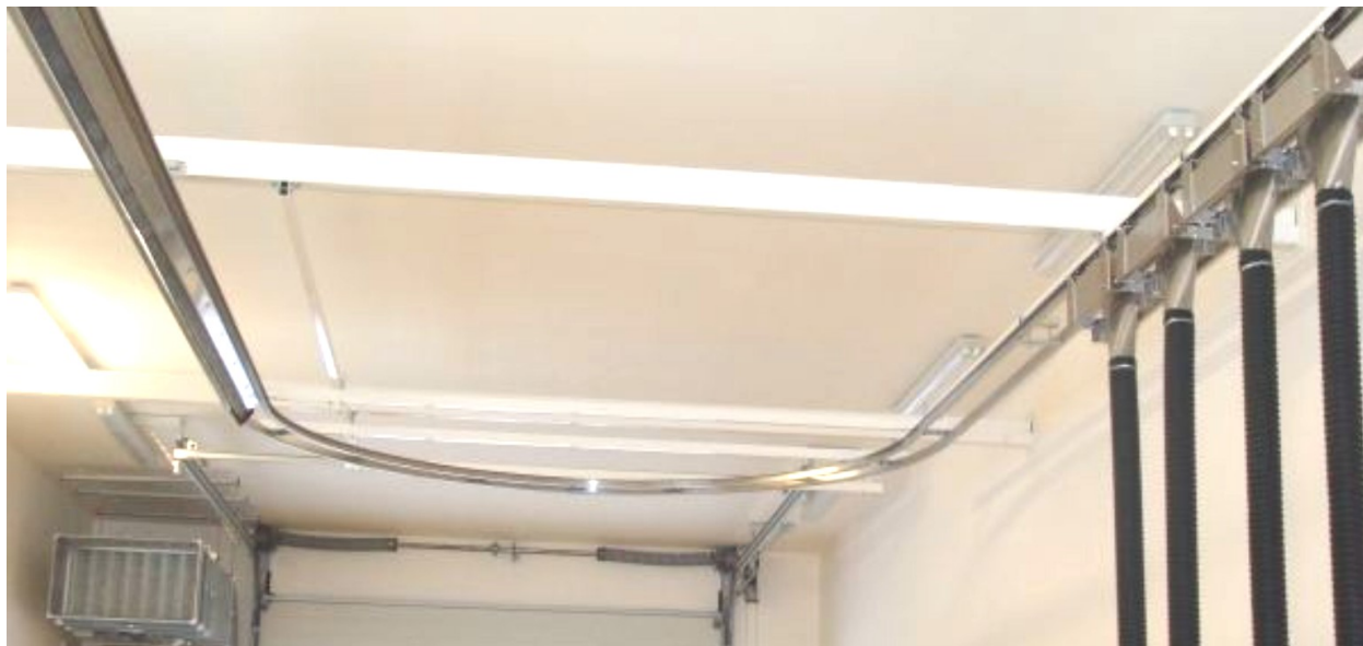
odsávací dráha s odsávacími vozíky a hadicemi
